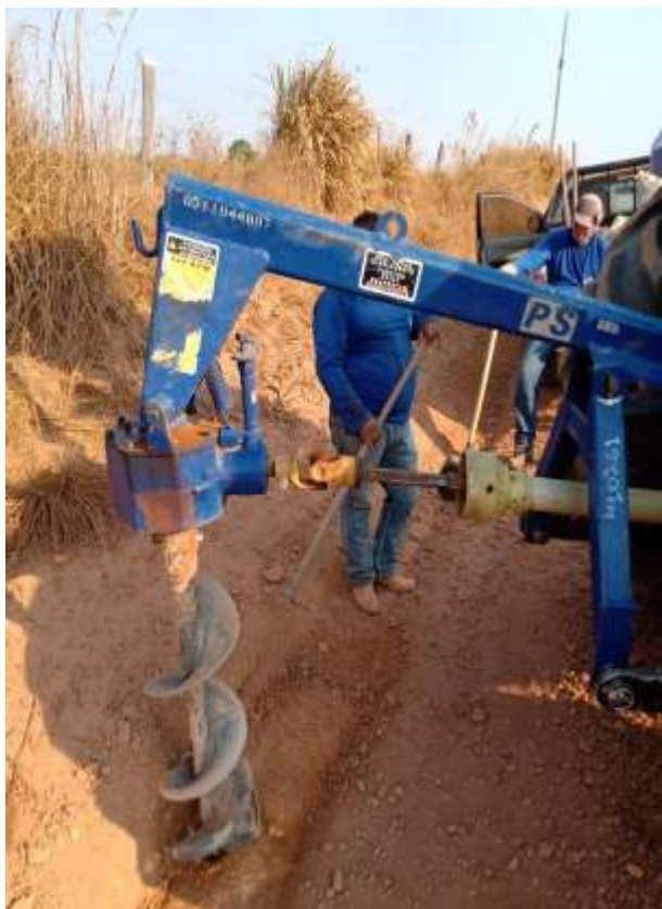
– Sondagem e Coleta de Amostra
