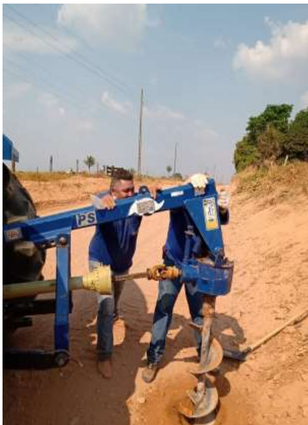
– Sondagem e Coleta de Amostra
