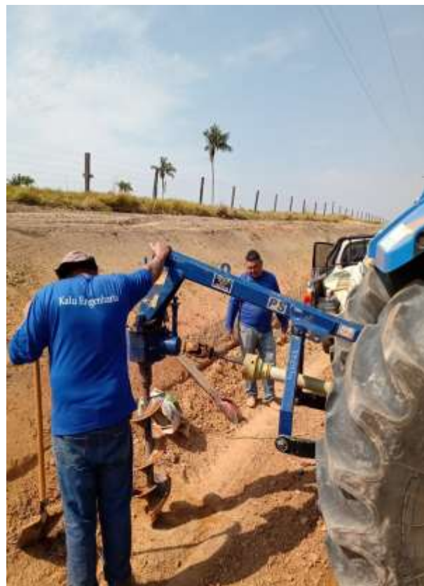
– Sondagem e Coleta de Amostra
